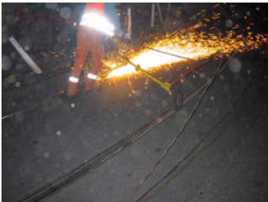
Foto 5. Semi-automatisch slijpen op locatie
