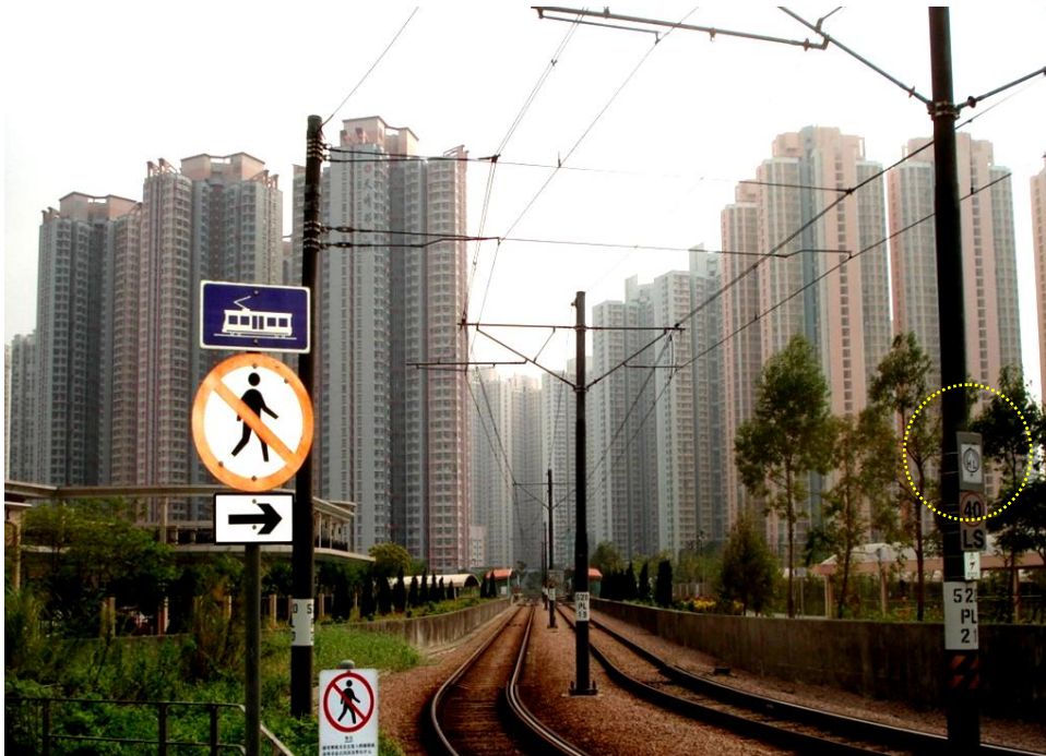
Foto 1: Hong Kong – de bestuurder activeert handmatig TOR-smering bij passage van het betreffende bord (geel omcirkeld).
