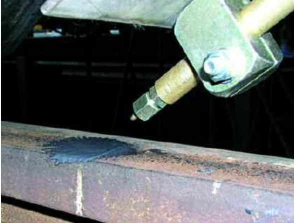
Foto 2: voertuiggebonden Top-of-Rail (TOR) smeerinrichting.
