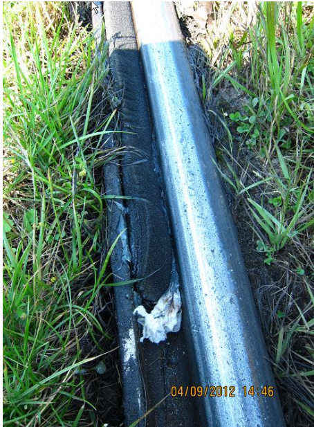
Foto 3: op diverse locaties in lijn 19 zijn delen van de groefrail (juist vóór het inrijden van krappere bogen) voorzien van smeerstrippen. Het betreft een sponsachtig materiaal verzadigd met smeermiddel; tijdens iedere wielpassage zal de passerende flens de strip indrukken waardoor zich smeermiddel op de flens zal afzetten. Dit rijdt vervolgens uit door de boog.
