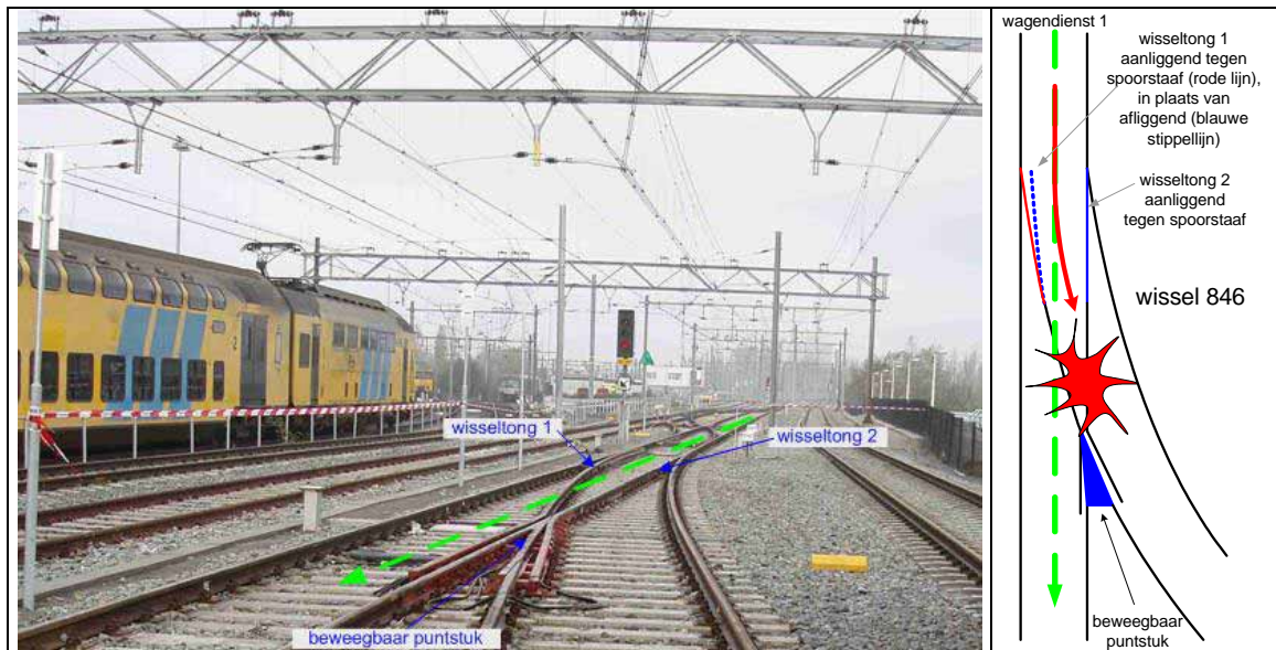
Afb.10: Wissel 846 de dag na de ontsparing, op de voorgrond is het beweegbaar puntstuk van het wissel zichtbaar (foto is gemaakt met de rijrichting van wagendienst 3 mee en tegen de rijrichting in van wagendienst 1: het ontspoorde railvoertuig).
