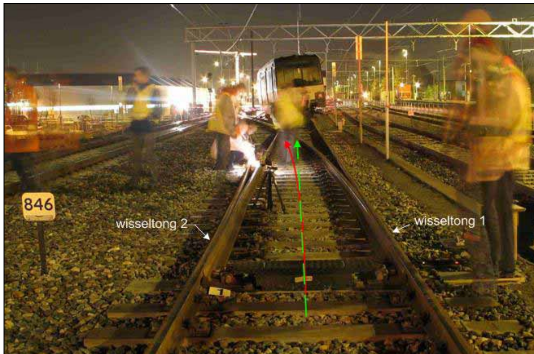
Afb.11: Wissel 846 (op de voorgrond) waarvan zowel wisseltong 1 als wisseltong 2 aanliggen, op de achtergrond is het ontspoorde railvoertuig te zien.
