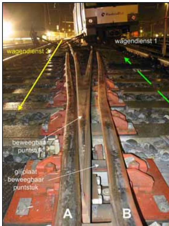
Afb.12: Beweegbaar puntstuk van wissel 846. Op de foto is zichtbaar dat het puntstuk tegen de spoorstaaf (A) aanligt. Wagendienst 3 is over het puntstuk gereden en heeft deze beschadigd.
